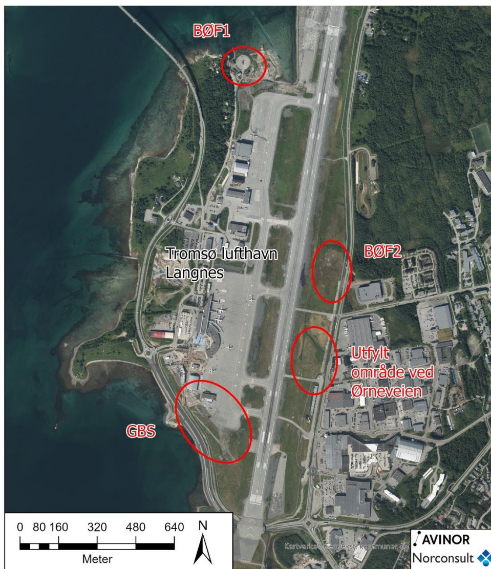
Figur 2-1. Lokalisering av sist nedlagte brannøvingsfelt (BØF1), gammelt brannøvingsfelt (BØF2), brannstasjon- og deice-område (GBS) og utfylt område ved Ørneveien ved Tromsø lufthavn.
