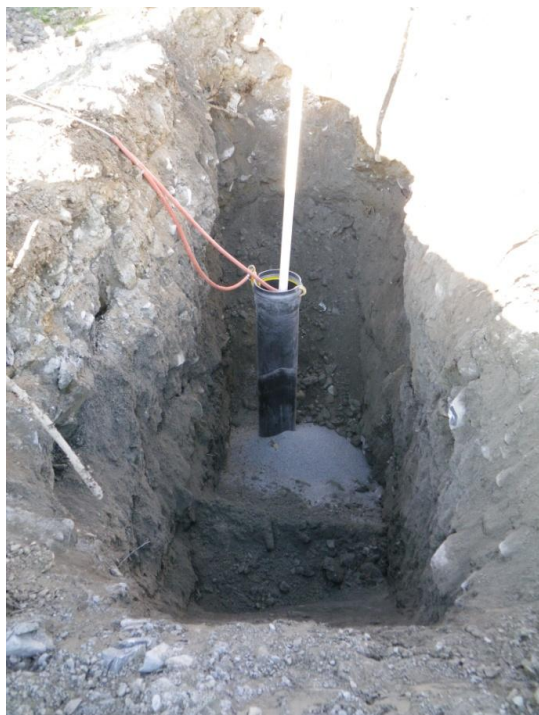
Figur 5. Etablering av miljøbrønn i sjakt1.
