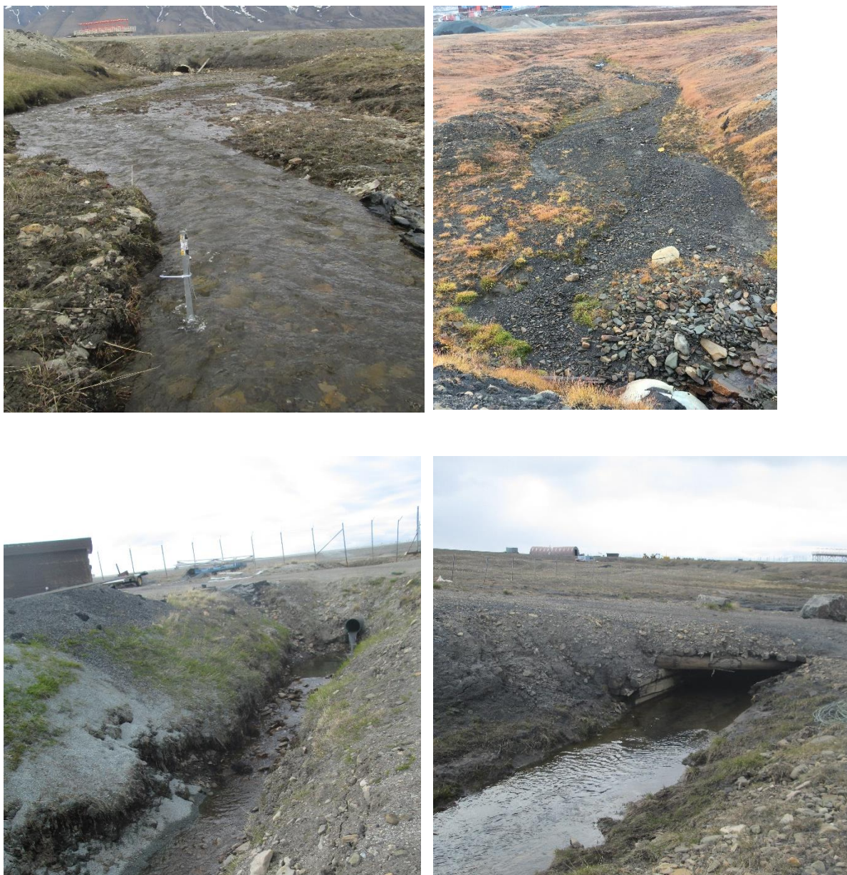
Figur 4-1: Øverste bilder: Bekkeløp fra aktivt brannøvingsfelt (BØF1 nedstr.) i juni 2017 (venstre) og september 2017 (tørt bekkeløp, høyre). Nederste bilder: Vannføring i kulvert fra rullebanen (Kulvert-RB øst) (venstre) og videre nedstrøms i L1 OV (høyre) i juni 2017.
