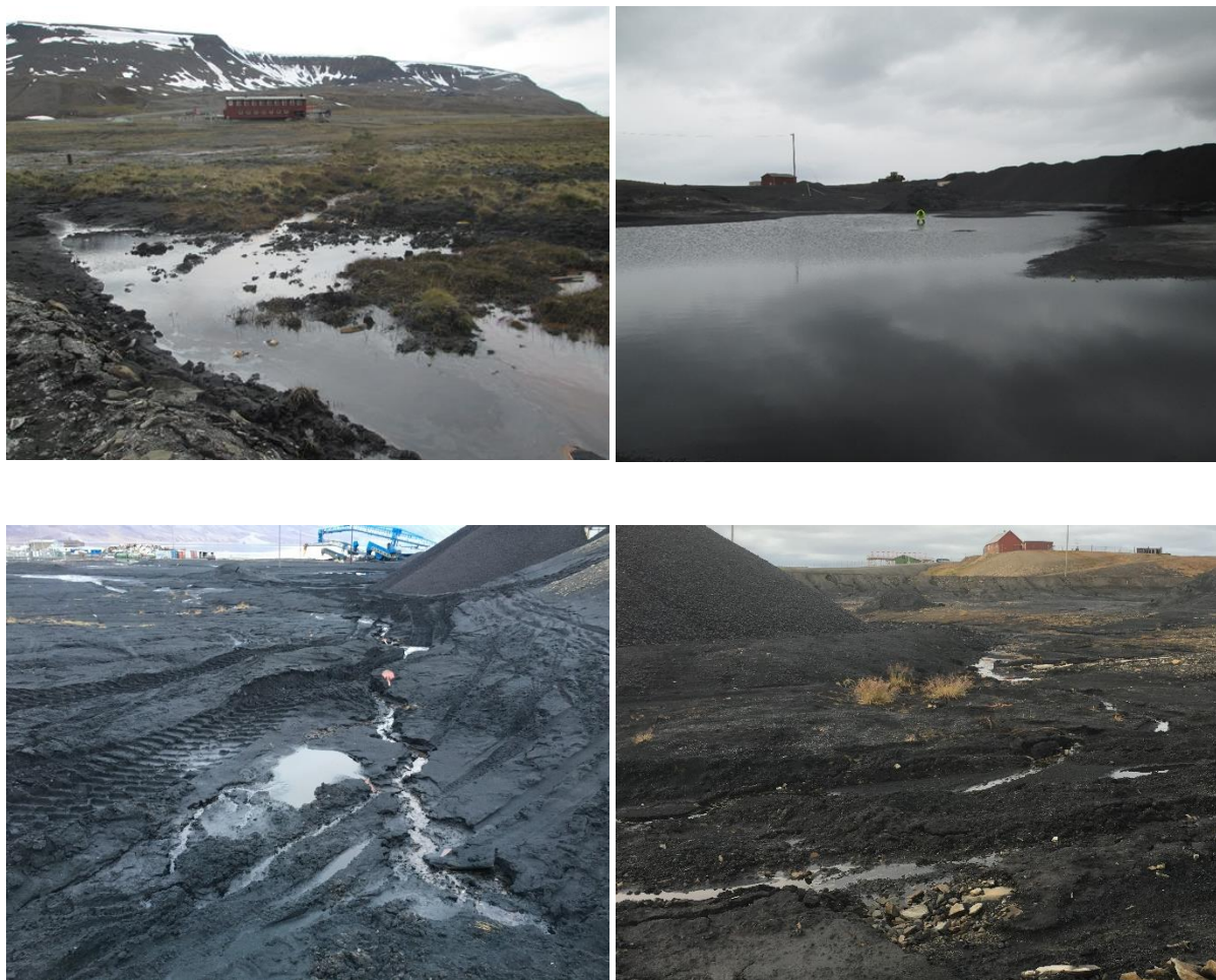
Figur 4-3: Øverste bilder: Stillestående vann i myrområde ved Gml. BØF nedstr. (venstre) og stor ansamling av vann på overflaten av Kullager Sør som observert i juni 2017 (høyre). Nederste bilder: Vannutslag og strømningsveier på kullageret, her som observert under forhold med lite vann på Kullager Midt (venstre) og Kullager Sør (høyre) i september 2016.
