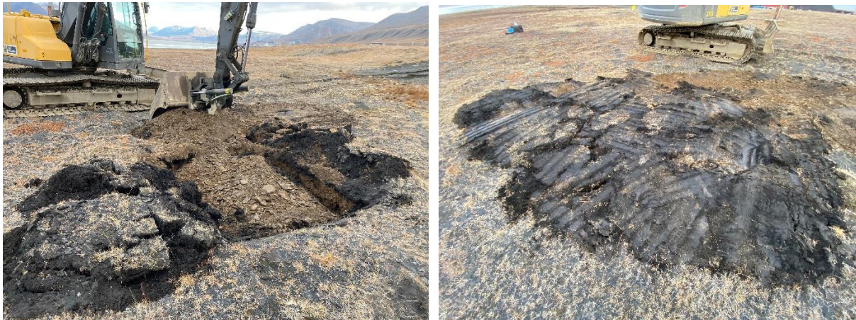
Figur 8. Etter prøvene var tatt ut og hullet fylt igjen, ble toppmassene og torvbitene lagt pent på plass før jorda ble forsiktig komprimert.
