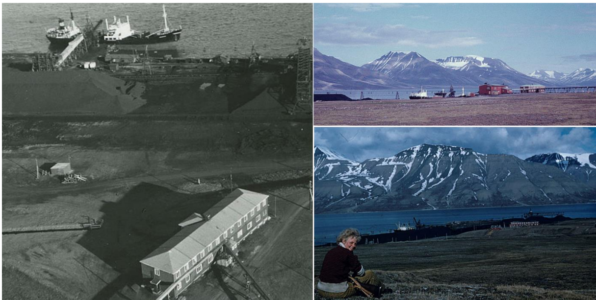
Bilde 9: Bilder fra Hotellneset 1957-1960 med området for brannøvingfeltet, hvor boligbrakken kan observeres. På bildet til venstre kan det også observeres en kanal som er anlagt fra boligbrakken i retning av Titankrana. Det er mest sannsynlig denne som er gjenfunnet under utgravningene Foto; Svalbard Museum ( https://bildearkiv.svalbardmuseum.no/fotoweb/archives/5000-Historiske-bilder/?q=hotellneset ).
