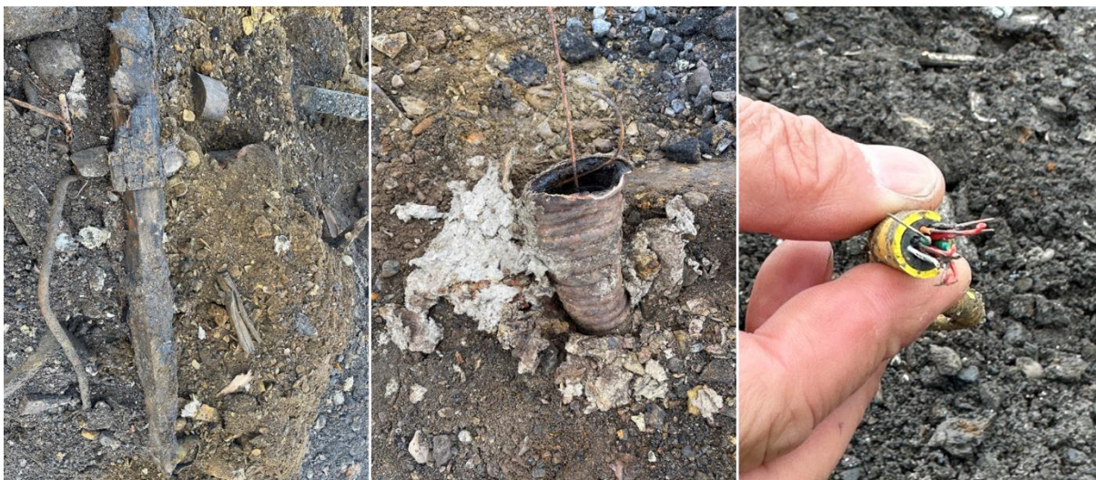
Bilde 7: Funn av objekter som indikerer at det ikke er snakk om rester etter automatisk fredede bygg. Til venstre ses delvis brent trevirke med rester etter plast/fuktsperre, i midten et armert plast/gummirør og til høyre en telekommunikasjonskabel av nyere dato (foto; Store Norske).
