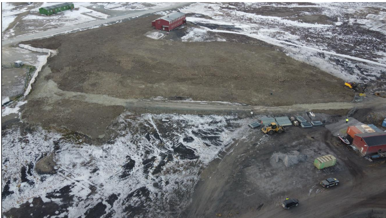
Figur 2-3: Tiltaksområdet slik det så ut i oktober 2023 etter tilbakefylling med tilførte masser (foto: SNSK).
