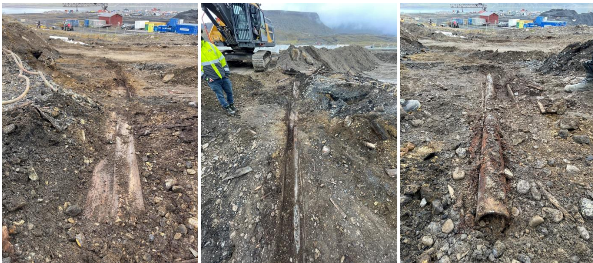
Bilde 8: Funn av rørgate/kanal i tre, med ilagt stålør/vannrør (foto; Store Norske).
