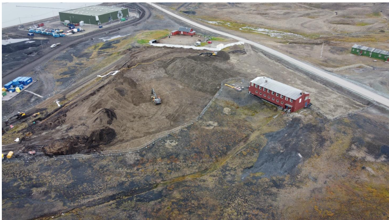
Figur 5-3: Tiltakets trinn 1 omfattet utgraving av masser ned til permafrost innenfor hele det aktuelle utgravingsområdet (foto: SNSK).
