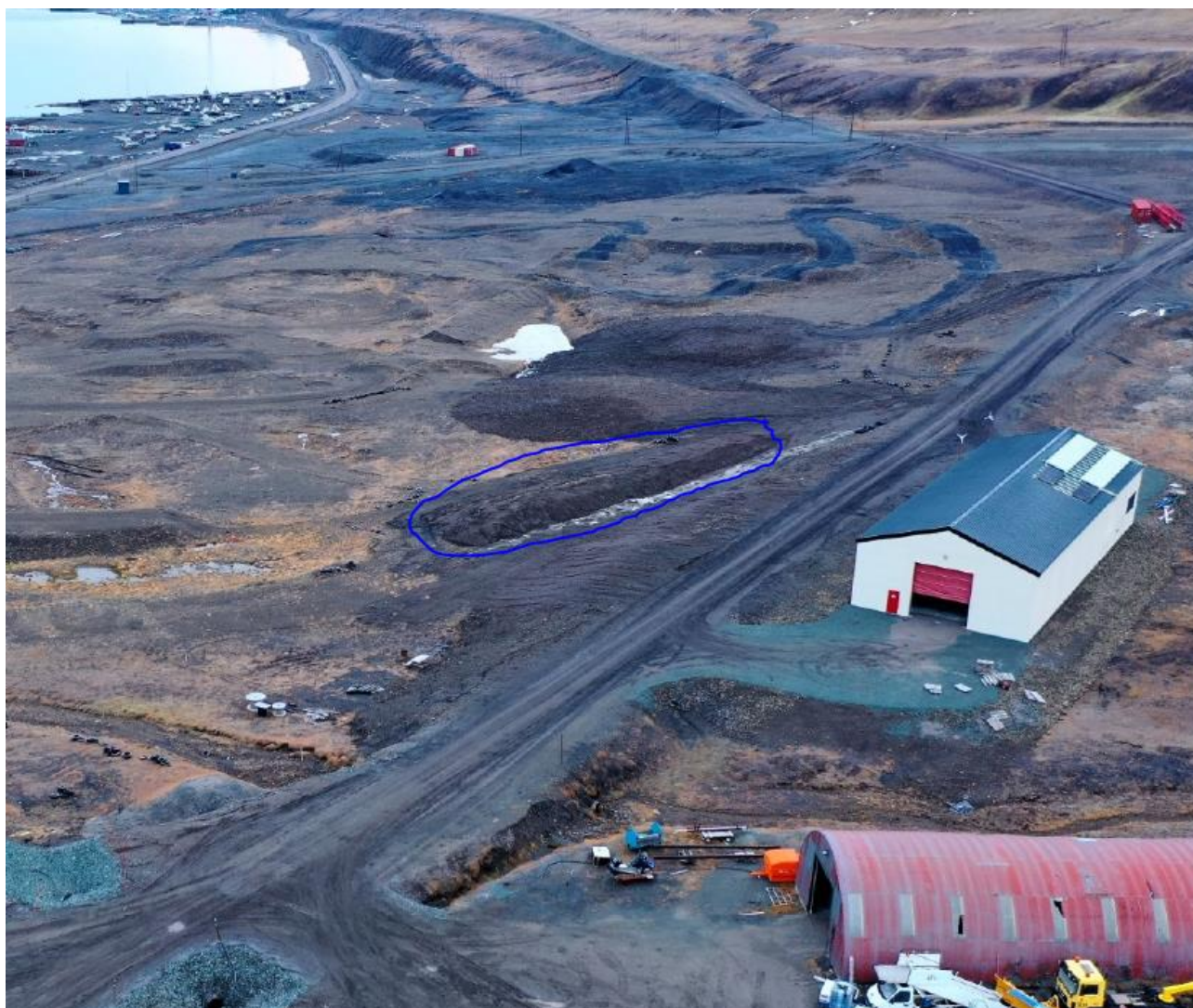
Figur 6. Toppmasser fra gravearbeidene inne på Longyearbyen lufthavn ligger lagret i ranker. Særlig ranken som er merket med blått i figuren vurderes som godt egnet.
