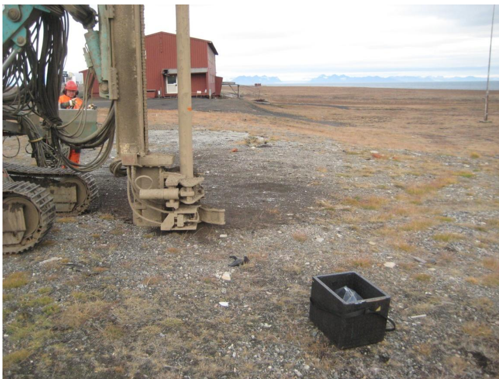
Figur 6. Boring av hull1. Grunnen består av grus over permafrost.
