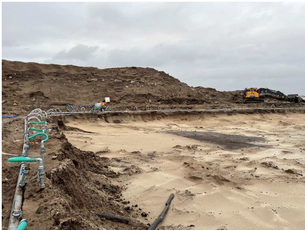
Figur 2-2: Sugespissanlegg for senkning av grunnvannsnivå for etappevis utgraving. Utpumpet grunnvann ble ledet til vannrenseanlegg (foto: Norconsult Norge AS, 21. oktober 2024).
