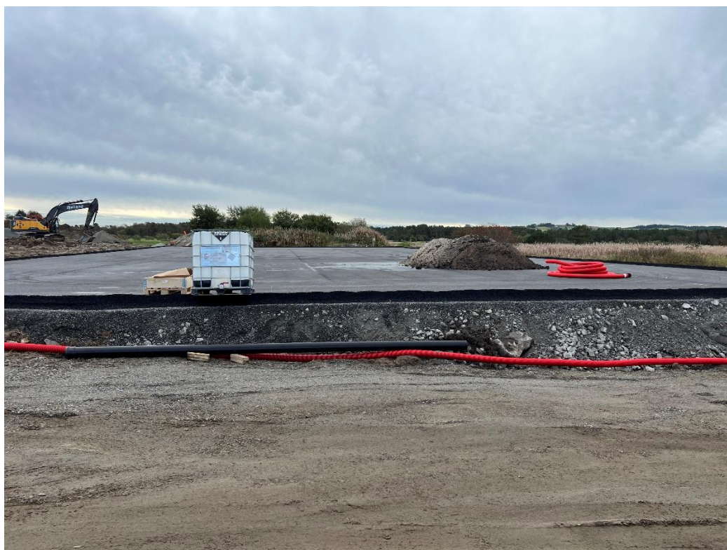
Figur 2-1: Etablering av asfaltert mellomlager for forurensede masser, med system for oppsamling av vann og videre påslipp til vannrenseanlegg (foto: Norconsult Norge AS, 26. september 2024).
