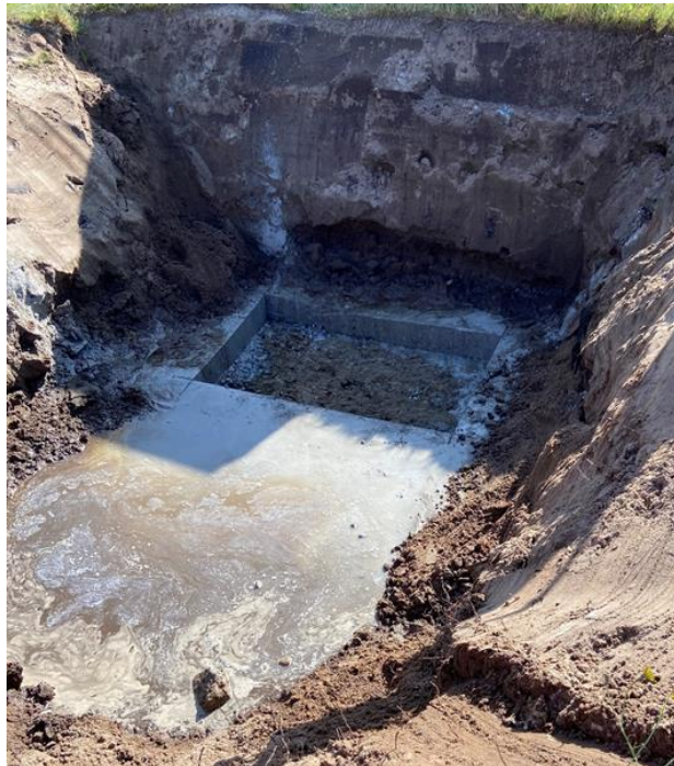
Figur 2-2: Avdekking av betongplate sentralt på feltet under prøvetaking i september 2020 (venstre bilde). Betongplaten ligger i dag overdekt av om lag 1,5 m tilførte masser. I henhold til mottatt tegningsgrunnlag ble avrenningsvann fra betongplaten ledet til oljeutskiller og videre til overvannsledning med utløp i Regebekken (utsnitt av tegning vist i høyre bilde).
