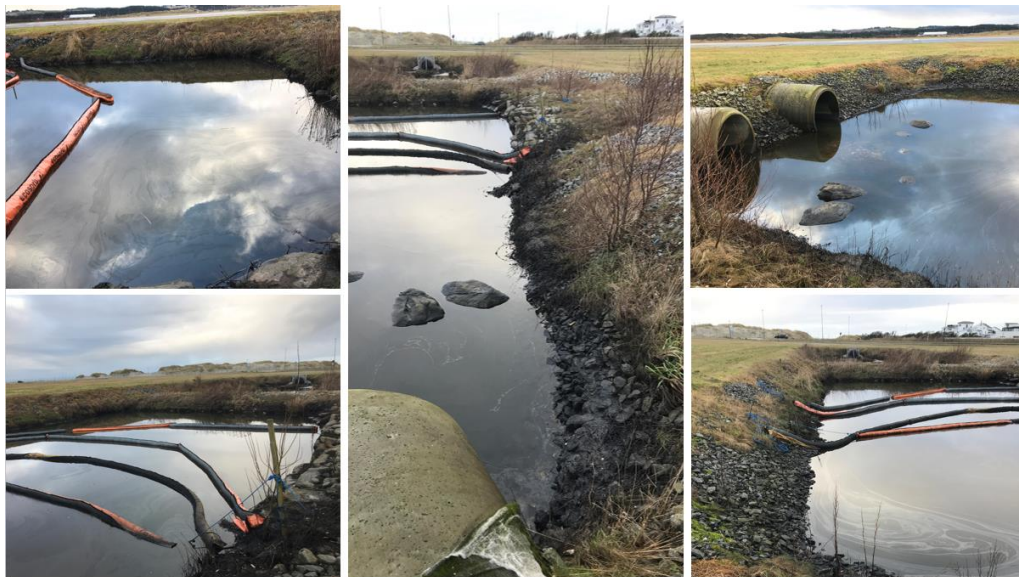
Figur 20: Bilder fra sedimenteringskammer den 29.01.2020. Oljefilm ble observert.
