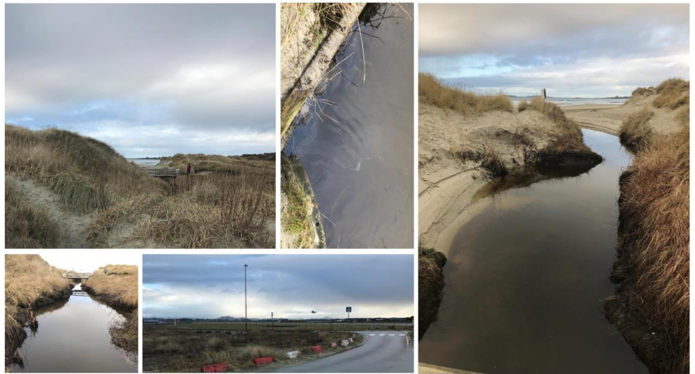
Figur 22: Utløp fra renseparken går i rør under Nordsjøvegen. Ved utløpet ble det observert litt oljefilm på vannoverflaten som kan skyldes drivstoff eller glykol. Det hadde vært avising av både rullebane og fly de to dagene i forkant av befaringen.
