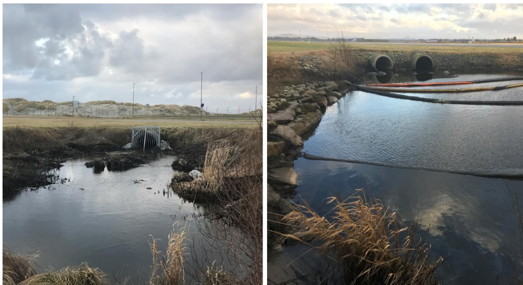
Figur 17: Venstre: Renseparken med utløp mot Solastranden bak rist. Høyre: Sedimenteringsbasseng med oljelenser. Noe oljefilm ble observert.
