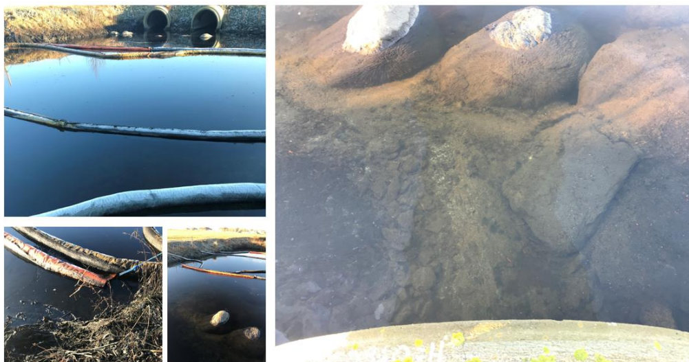
Figur 14: Sedimenteringsbasseng i forkant av rensedam. Oljefilm og tyngre klumper med oljeluktende masse ble observert.
