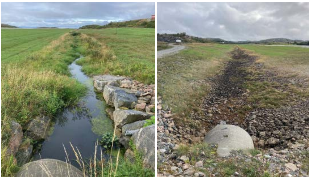
Figur 5-8: Bekken vest for rullebanen ved prøvetaking i august 2021. Prøvepunkt vann 1 hvor bekken renner ut av kulvert i bildet til venstre og prøvepunkt V-4 ved utløp til sjø i bildet til høyre.
