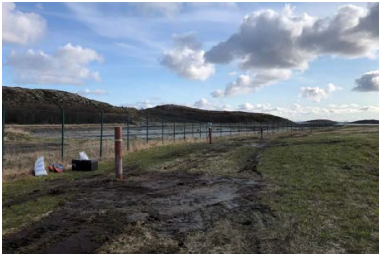
Figur 5-1: Lokalisering av miljøbrønner øst og sør for BØF 2 (bilde tatt rett etter etablering, før kutting av foringsrørene).
