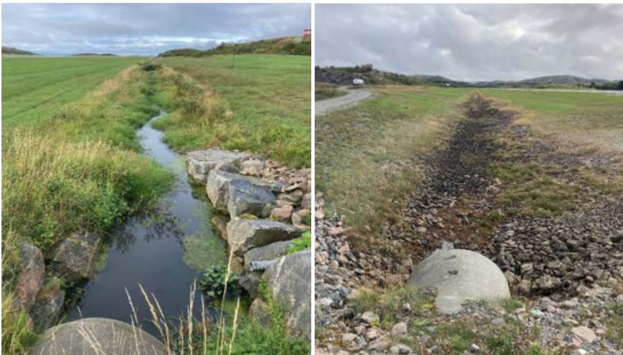
Figur 3-4: Bekken vest for rullebanen ved prøvetaking i august 2021. Prøvepunkt vann 1 hvor bekken renner ut av kulvert i bildet til venstre og prøvepunkt V-4 ved utløp til sjø i bildet til høyre.
