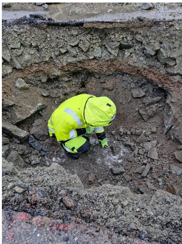
Figur 5-2: BØF-SJ09, forsterkningslag og fyllmasser på p-plass over berg.
