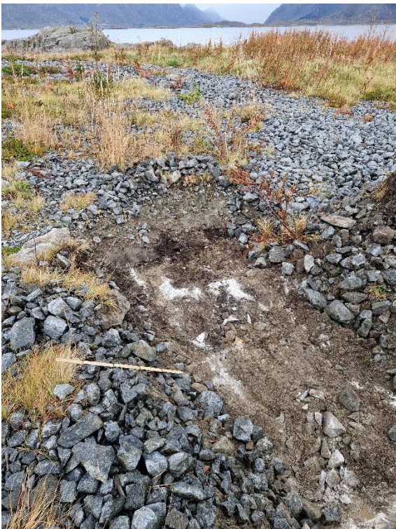
Figur 5-3: BØF2-SJ01. Tynt løsmassedekke over berg, øst på BØF2.
