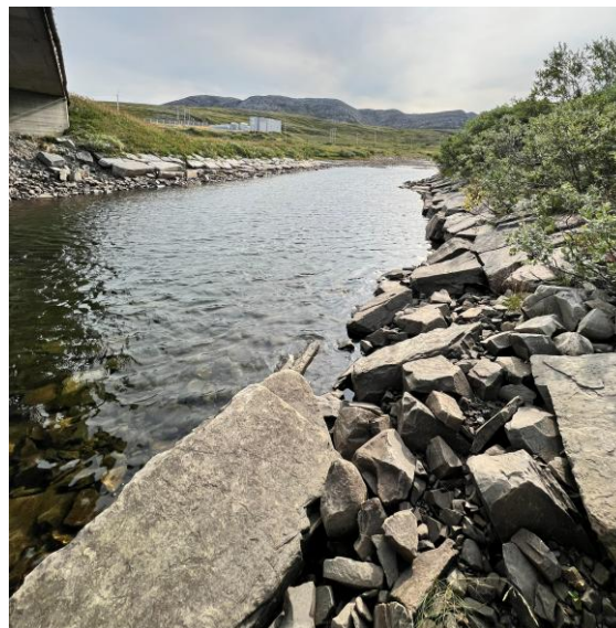
Figur 5-8. Prøvepunkt V2 (under bru) i august 2024, sett oppover elva.
