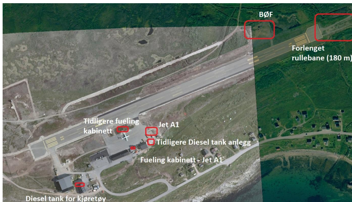
Figur 1: Vadsø flyplass med plassering av brønnøvingsfelt.
