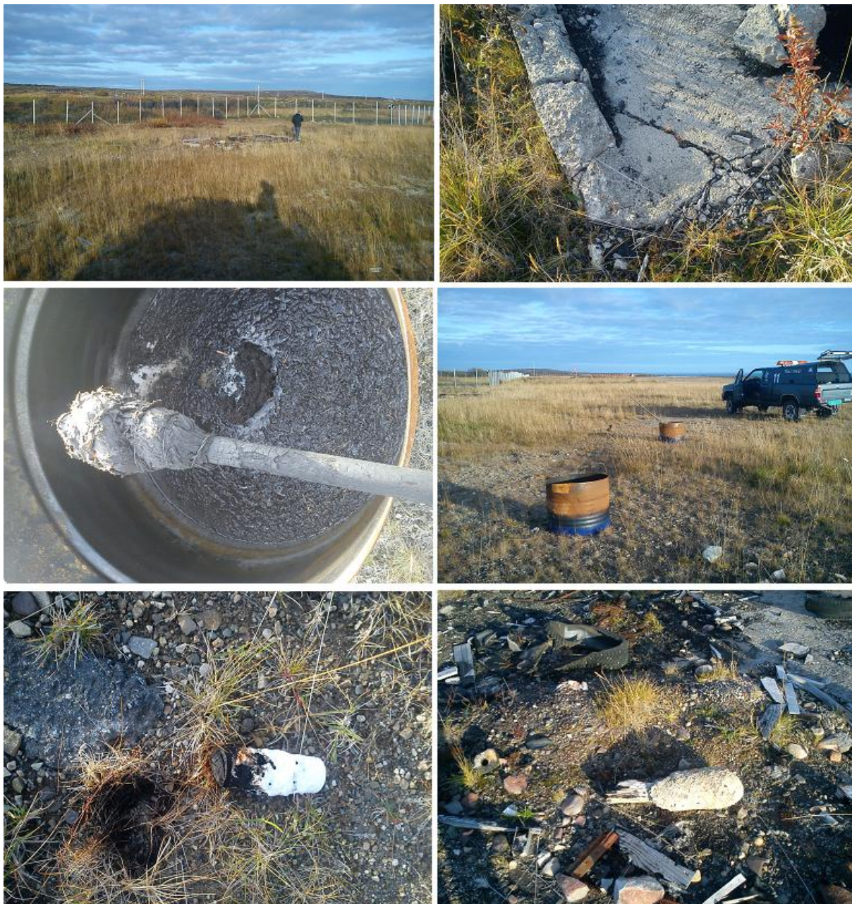
Figur 5. Vadsø BØF-området. Bildene viser plassering av betongsålen og sålens tilstand, halvtønner med antenningsveske, -lunte og skrot på betongsålen.
