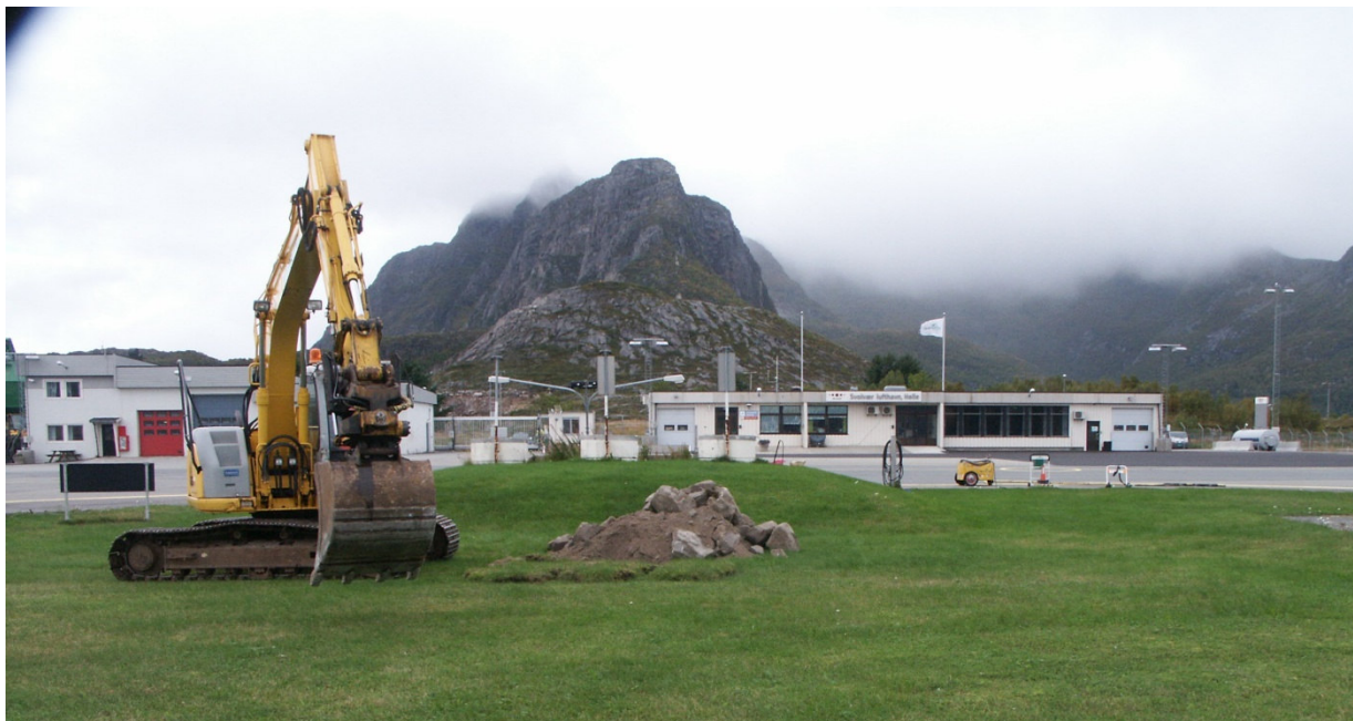
Figur 1 prøvesjaktrett nedstrøms tankanlegg for flydrivstoff. Til høyre i bakgrunnen vises dieseltank for kjøretøy, som har fått ny plassering med påkjørselsvern.
