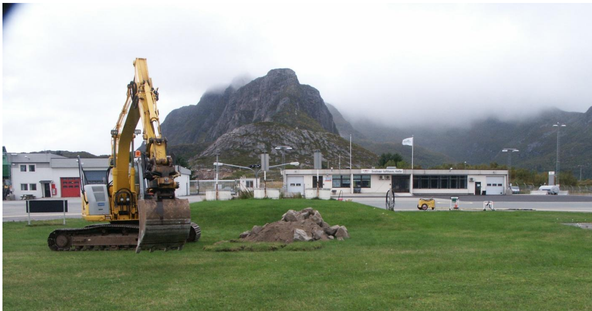
Figur 2. Prøvesjaktrett nedstrøms tankanlegg for flydrivstoff. Til høyre i bakgrunnen vises dieseltank for kjøretøy, som har fått ny plassering med påkjørselsvern
