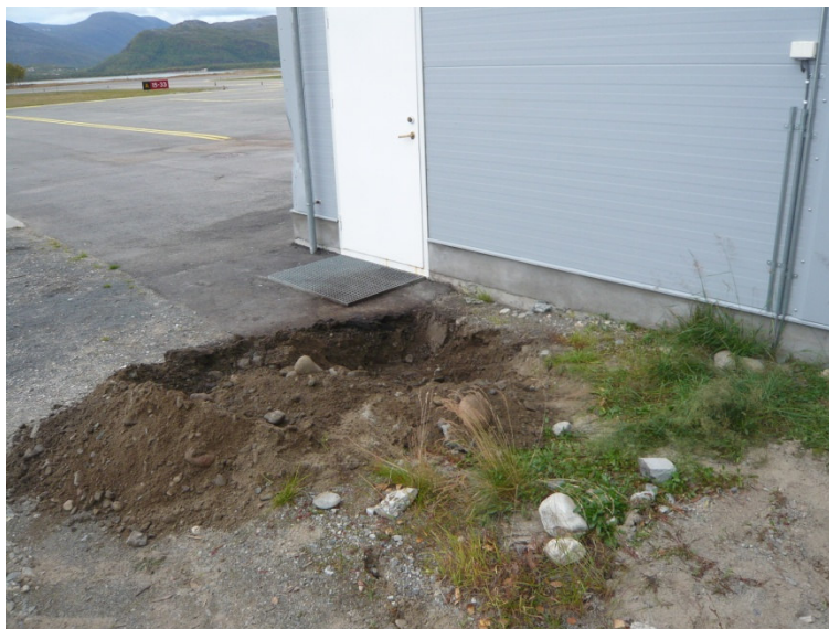
Foto 1: Gammel standplass dieseltank kjøretøy med synlige overflateforurensninger.
