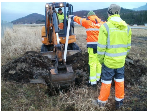
Figur 2: Nedsetting av brønn i kanten av brannøvingsfeltet
