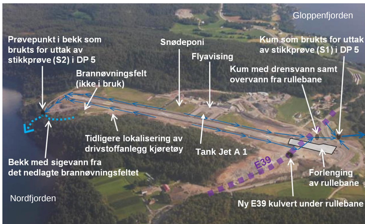
Figur 1. Oversiktsbilde mot syd av Sandane lufthavn
