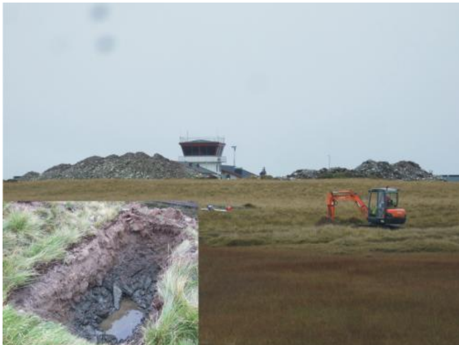
Sjakt 4 sett mot terminalbygget
