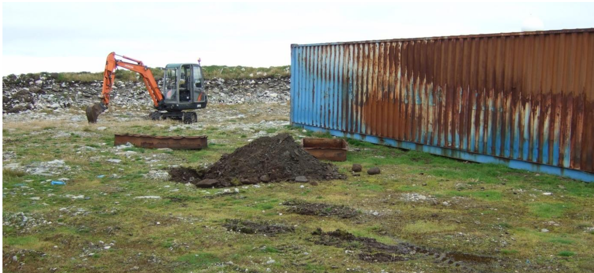
Figur 4: Yngre brannøvingsfelt - det er synlig to brannkar bak sjakt 3. Sjakt 4 graves.
