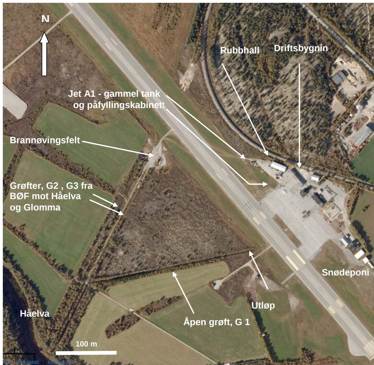
Figur 1. Oversikt over Røros Lufthavn
