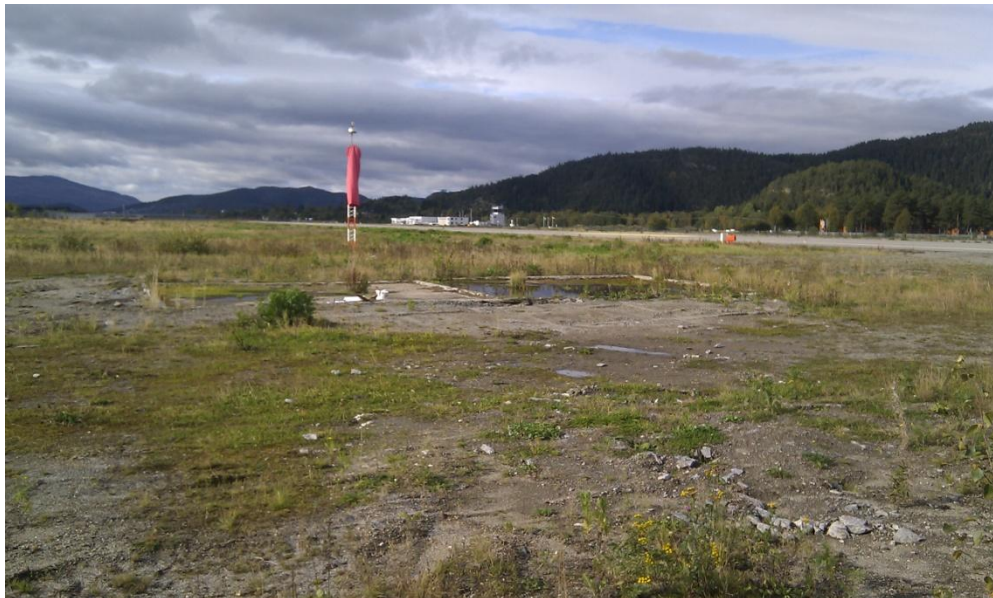
Figur 2. Oversiktsbilde mot vest som viser gammelt brannøvingsfelt.
