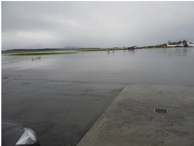
Figur 3: Oppstillingsplass og snødeponiet i bakgrunn (sjaktarbeider med gravemaskin).
