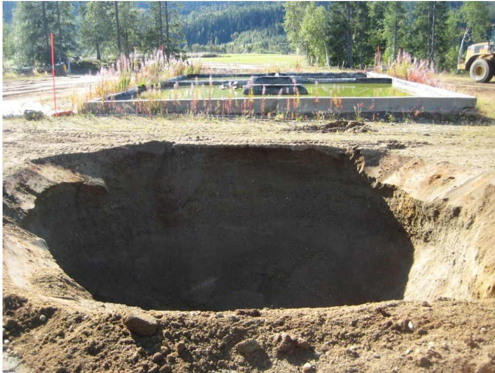
Figur 2. Oversiktsbilde mot sydvest (rullebanen) som viser plattformen på brannøvingsfelt. Sjakt 7 i forgrunnen viser de øvrige meter av den mektige løssmasseavsetningen under flyplassen.
