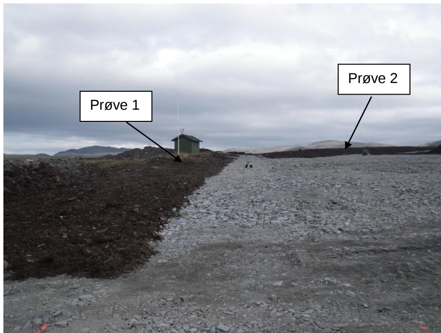
Figur 3 Tilbakefylt toppmasse (til venstre og i bakgrunnen) etter tiltaksarbeider på brannøvingsfeltet
