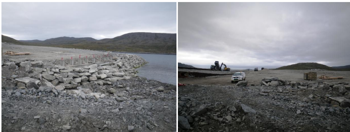
Figur 2 Utfylling for utvidelse av rullebane med erosjonssperre i nord over tidligere brannøvingsfelt
