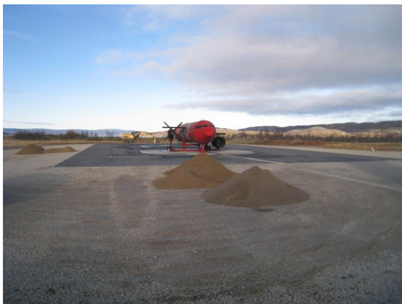
Figur 3: Brannøvingsfelt i Lakselv sett mot nord, med Sj1 i forkant av bildet.
