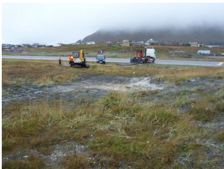
Snødeponiet 1 med utløp mot sjø til høyre.
