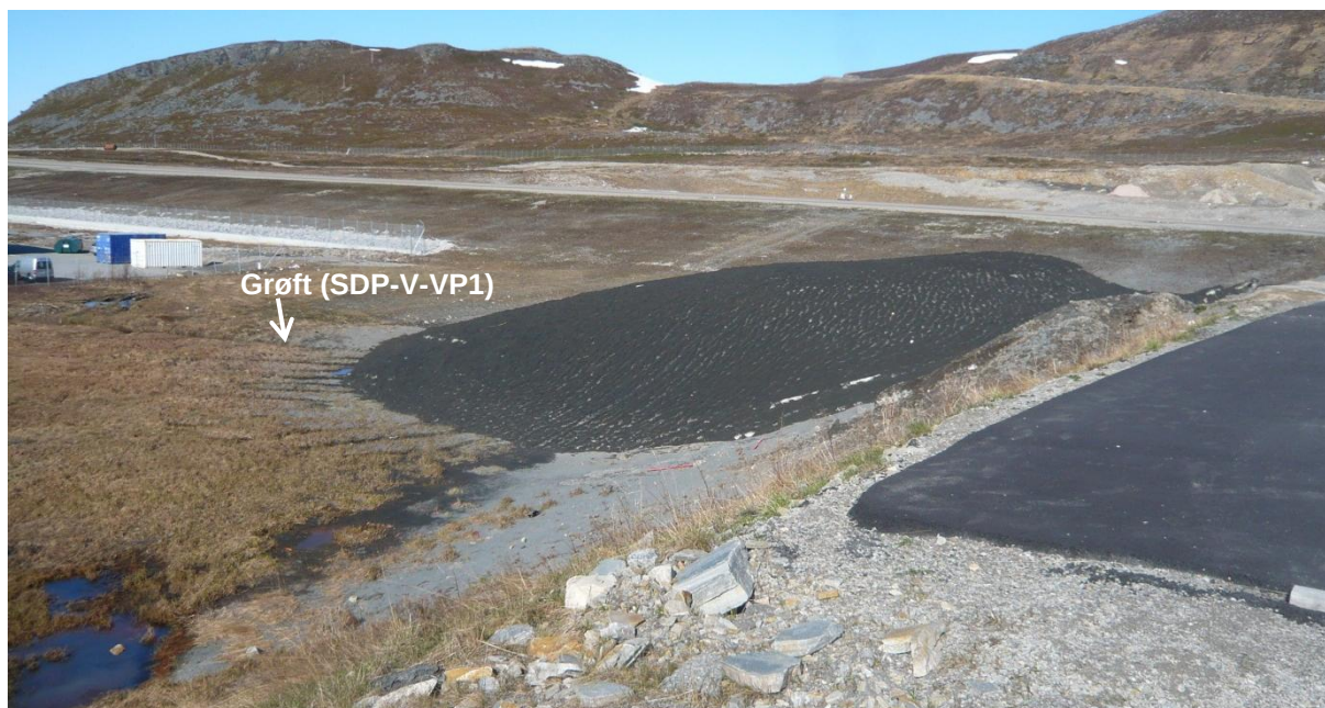
Figur 3: Snødeponi 2 (vest) – Hammerfest, sett mot vest-nordvest.
