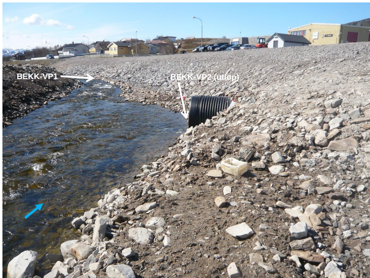
Figur 4: Flyplassens utløp til bekken (sort rør) – sett mot sørvest.
