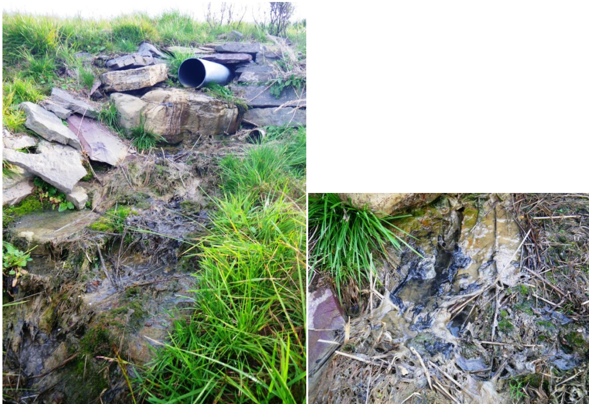
Figur 2 Båtsfjord lufthavn – infiltrasjon til grunnen fra oljeutskiller
