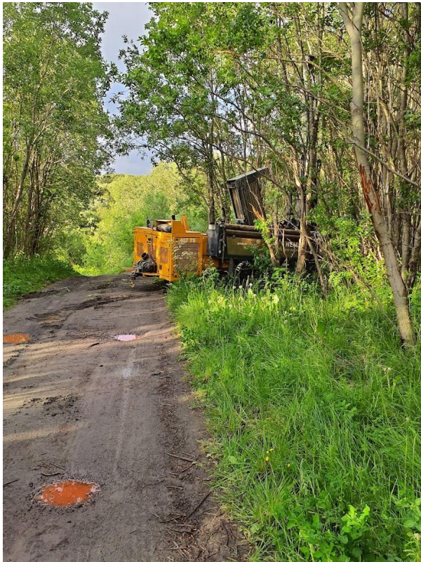
Bilde 1: Oversikt over boring av BR10
