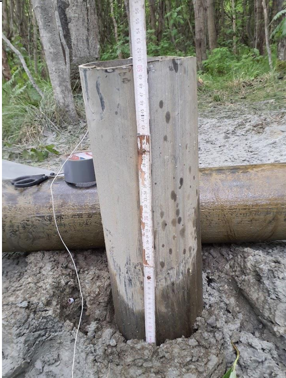
Bilde 3: 0,5 meter over terreng
