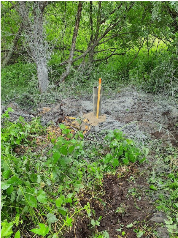
Bilde 2: Ferdig etablert brønn
