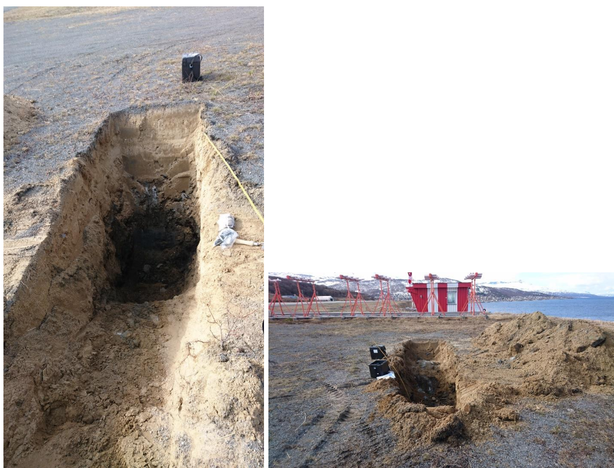
Figur 3: Bilde av sjakt M27 til venstre, og M28 til høyre (Rambøll mai 2017)
