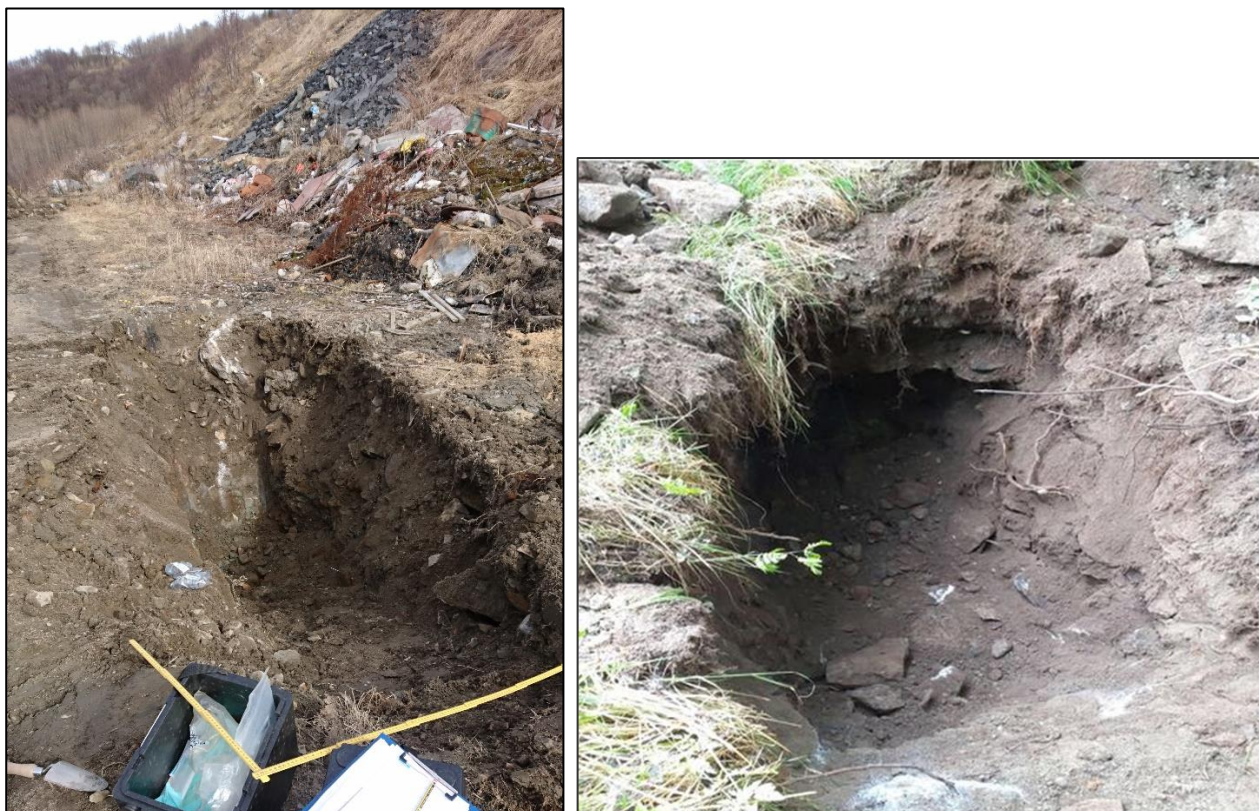
Figur 12. Bilde av sjakt M43 til venstre, og S3 til høyre (Rambøll mai 2017 og juni 2020).
