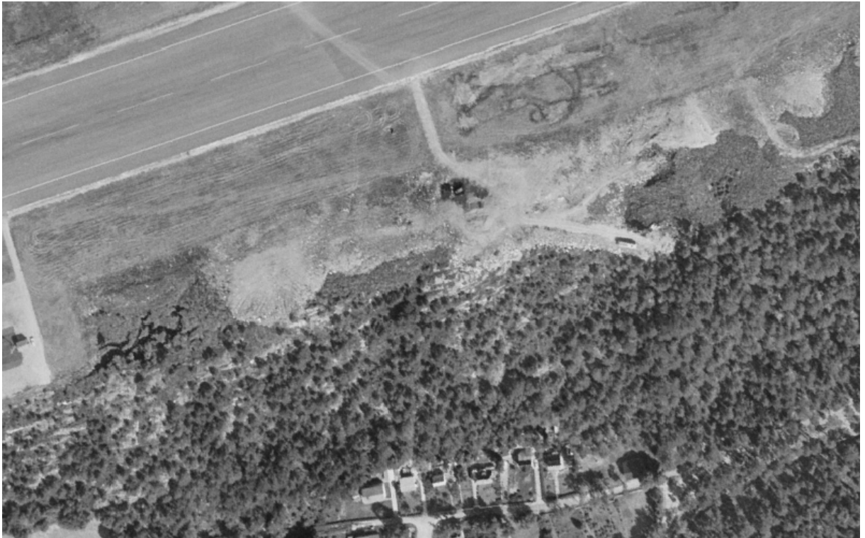
Figur 9: Bilde over området som omfattes av tiltaksområdet fra 1972. Bildet viser kjørespor på store deler av området nord for skogsmarka, og også at det er fylt på masser langs veiene. Kilde: [11]
