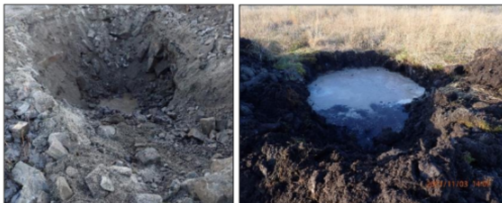
Figur 8: Bilder fra tiltaksområdet. T.v.: Det sentrale området hvor det er fylt på med sprengsteingsmasser. T.h.: Et område i den vestlige delen av tiltaksområdet hvor jordmassene inneholder torv. Kilde: [1]
