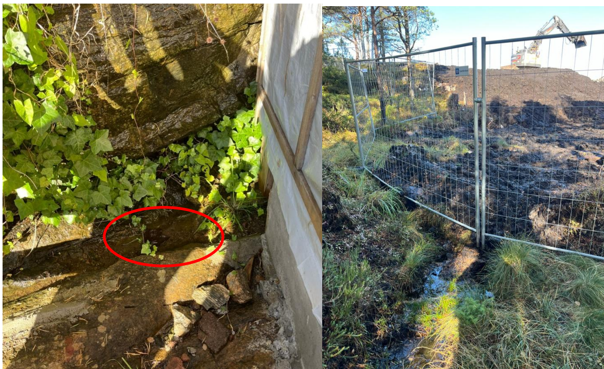
Figur 11 Vs: Prøvepunkt 34/114 Vann. Sprekk i fjellet i Nordmørsveien 165. Hs: Foto av prøvepunkt «anl.vann» oppe ved anleggsgjerdet.
