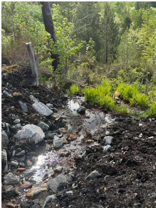
Figur 10: Pumpesump 1 er fjernet og bekkeløpet mot kummen ved velforeningen er reetablert. Bilde: Avinor 28.05.25.
