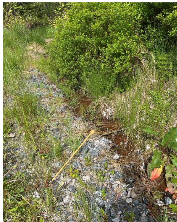
Figur 8: Grøft som leder vannet fra sumpen til Nordmørsveien (Pkt. 15, Figur 2).
