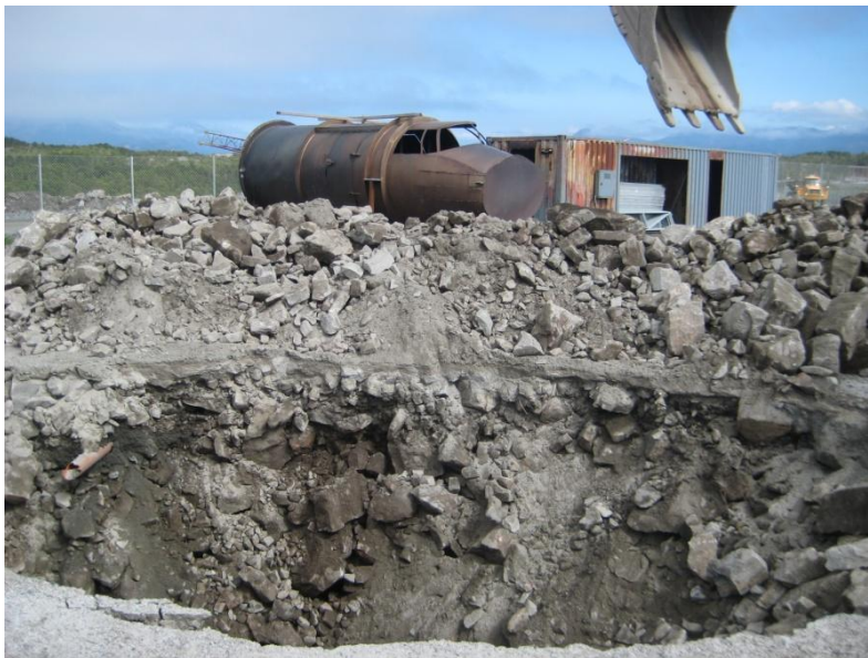
Figur 2 Fyllmasser under BØF-1 består av stein, grus og sand.
