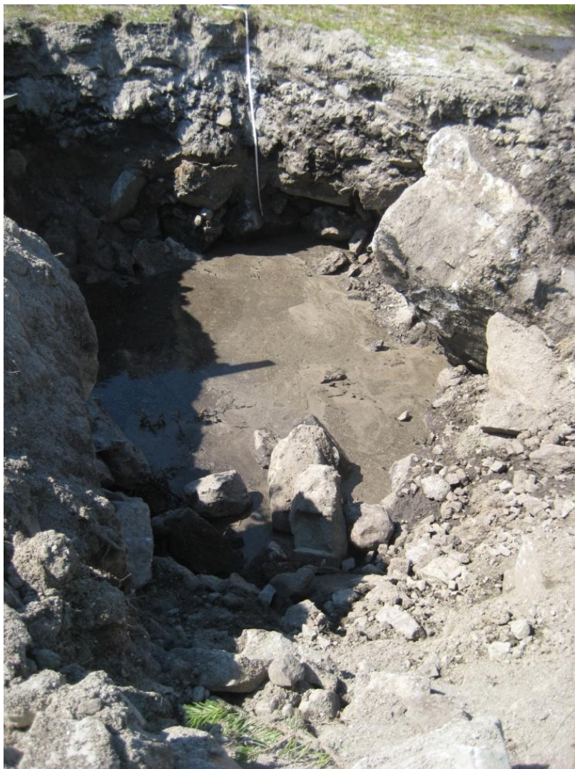
Figur 4. Grunnen består av fyllmasser: steinblokker, grus og sand.
