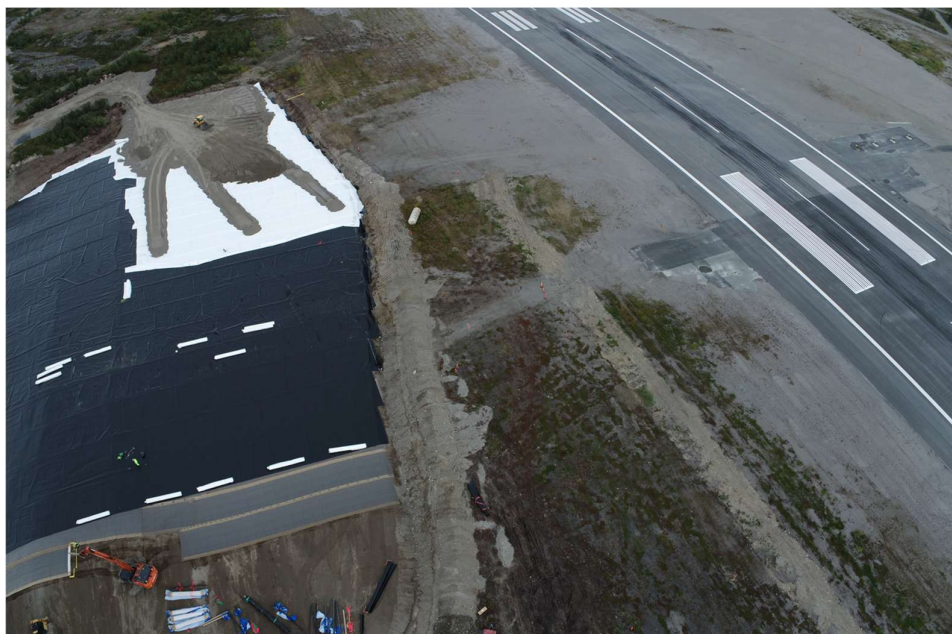
Figur 2-3: Tildekkingstiltak ved Kirkenes lufthavn. Nærmest bentonittmembran (grått), HDPE-membran (svart), beskyttelsesduk (hvitt) og tildekkingsmasser (grått).
