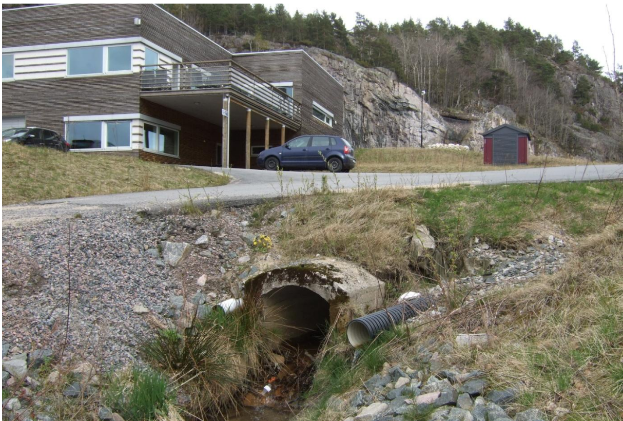
Figur 10: Bilde som viser utløpspunktet for overvannsledning mot Topdalsfjorden
