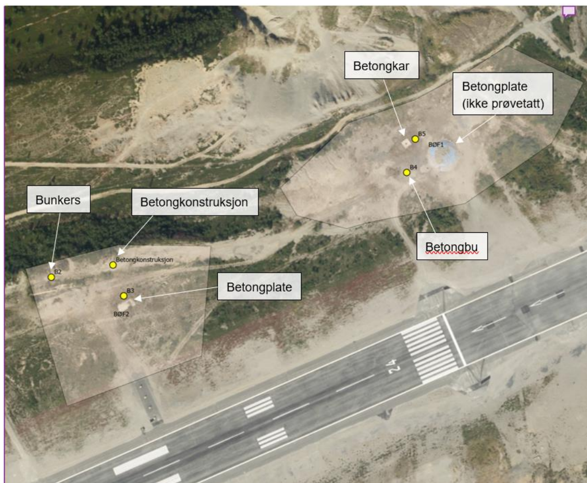
Figur 14 Betongprøver prøvetatt 19.11.2024. For beskrivelse av prøvepunktene, se Tabell 2. Betongplaten på BØF1 ble ikke prøvetatt ettersom denne var tildekket av mellomlagrede masser på prøvetakingstidspunktet.
