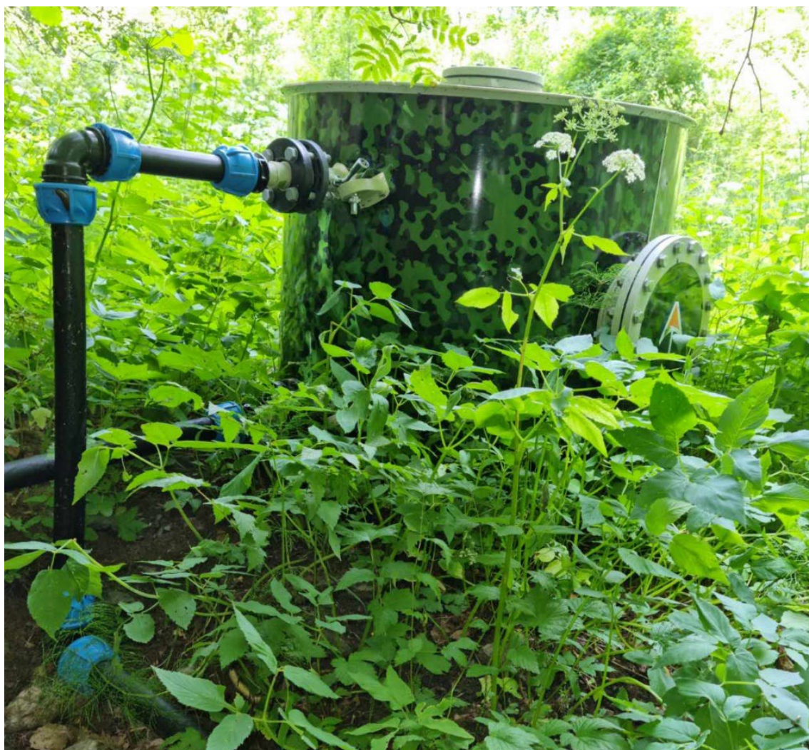
Figur 75 Eksempel på et passivt system med en isolert tank som er klargjort for å stå ute.
