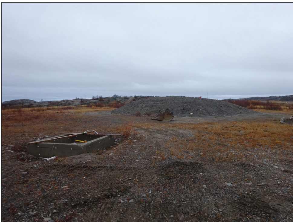
Figur 7. Oversiktsbilde over det gamle brannøvingsfeltet (BØF1) på Kirkenes lufthavn. Bildet er tatt i oktober 2021 i forbindelse med miljøundersøkelser på området. Haugen midt i bildet er mellomlager av PFAS-forurensede masser. Duken er dekket med sand og grus for beskyttelse.
