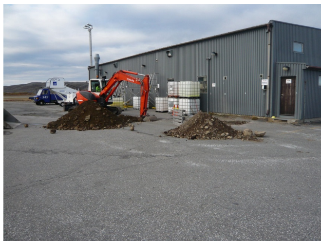
Figur 7: Sjaktarbeider ved SAS-driftsbygg.
