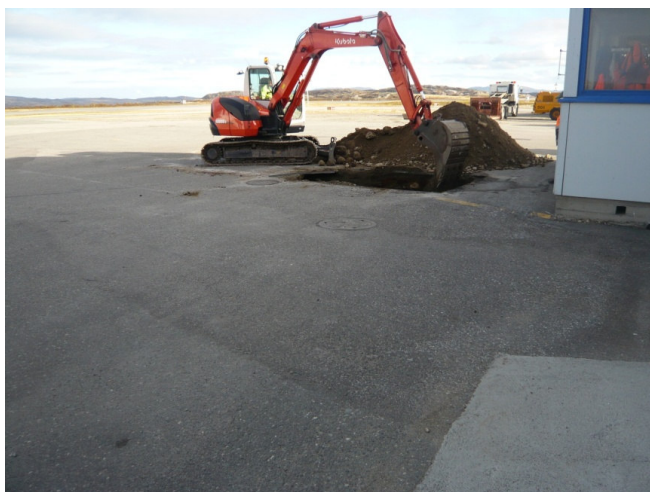
Figur 6: Sjakting ved oljeutskilleren ved Avinors verksted
