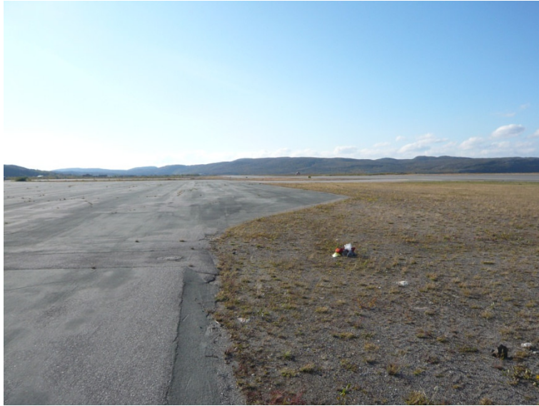
Figur 3: Gammelt snødeponi bak kanten av den gamle oppstillingsplassen og taksbanen.
