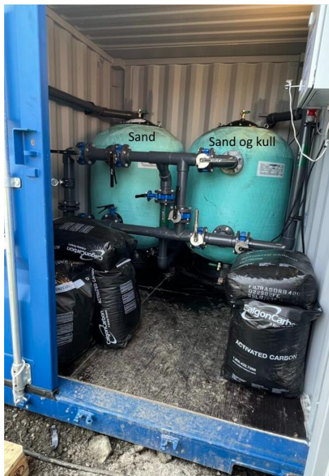
Figur 8. Arrangement for oppsett av vannrenseanlegg for PFAS-forurenset vann fra gravegrop (BØFB) ved Haugesund lufthavn 2023.
