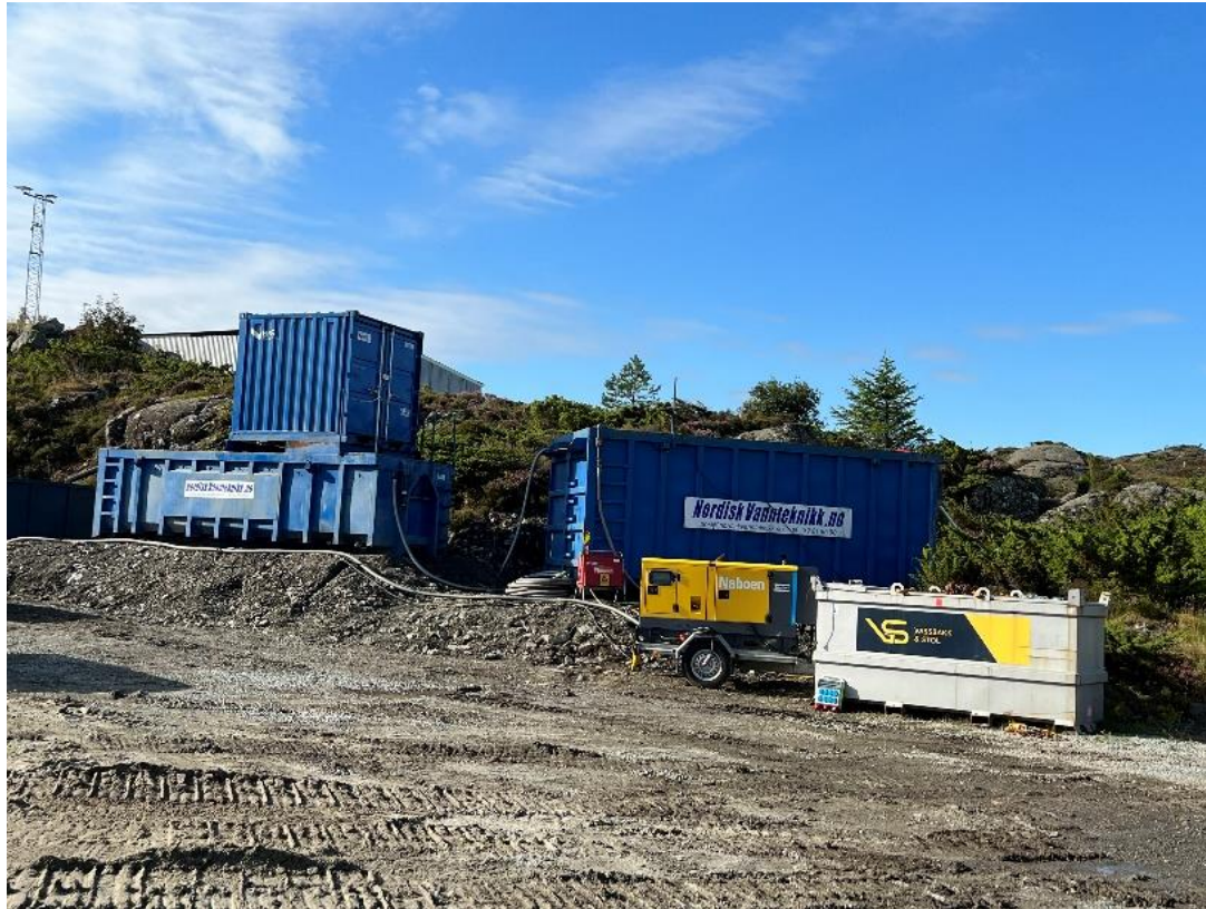
Figur 8. Arrangement for oppsett av vannrenseanlegg for PFAS-forurenset vann fra gravegrop (BØFB) ved Haugesund lufthavn 2023.
