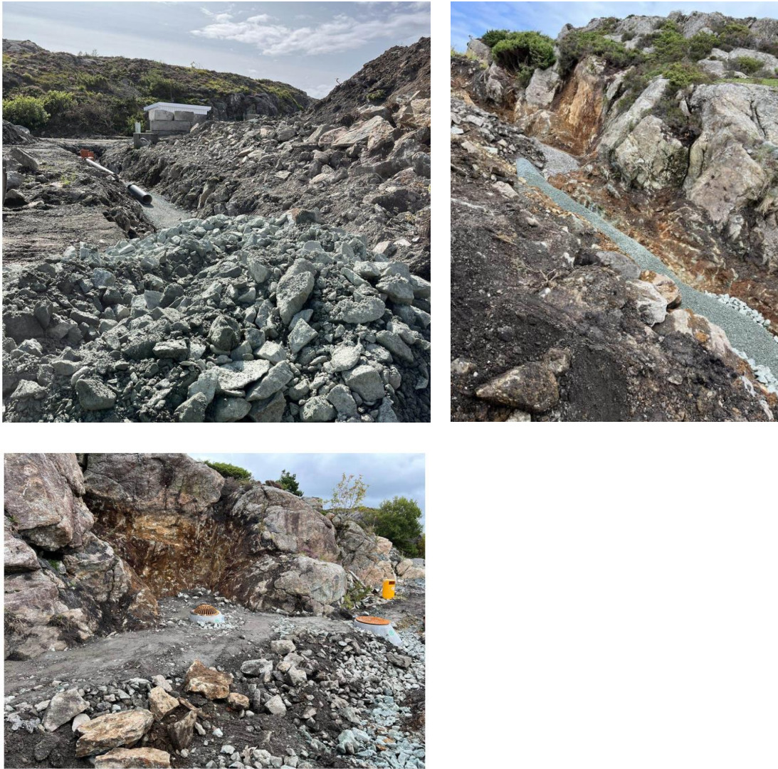
Figur 6. Nedlegging av rør for overvann utenfor tiltaksområdet (øvre bilde), for håndtering av overvann fra omkringliggende nedbørsfelt (høyre bilde, se Figur 7 for ferdigstilling av grøft) til OV3 (nedre bilde), ved BØFB Haugesund lufthavn som forberedelser til utgraving av PFAS-forurensede masser høsten 2023.
