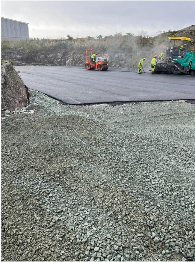
Figur 11. Klargjøring med asfaltering av delområde 1 for utsortering av grov stein fra PFAS-forurensede masser ved BØFB Haugesund lufthavn høsten 2023.
