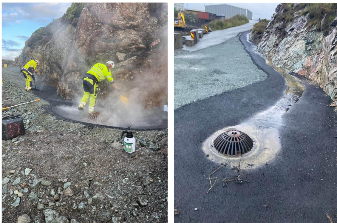
Figur 7. Asfaltering av grøft mot fjell (mot øst) for håndtering av overvann fra omkringliggende område (venstre bilde), tilsvarende grøft mot vest (høyre bilde) og dens funksjonalitet, utenfor tiltaksområde BØFB ved Haugesund lufthavn, høsten 2023.
