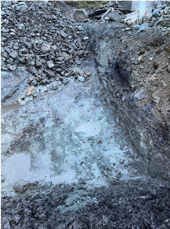
Figur 13. Graving til fjell eller siltig leire før igjenfylling med grove rene masser. Leiren ble prøvetatt for å dokumentere at grunnen var under tiltaksgrensen for PFAS ved BØFB, Haugesund lufthavn høsten 2023.
