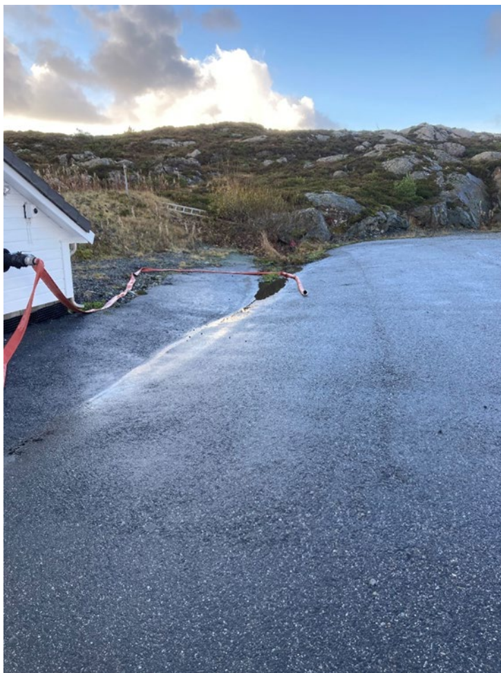
Figur 7. Avrenning fra BØFA ved Haugesund lufthavn 2021. Vannet blir stående i drenslinjen og siger sakte ned i grunnen istedenfor å ledes til kum og oljeutskiller.
