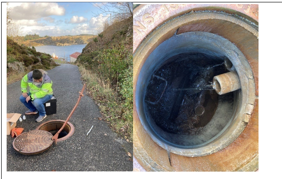
Figur 9. Kum nedstrøms BØFB ved Haugesund lufthavn 2021 (stasjon BØFB-KU1-V1). Flere rør fra oppstrøms områder munner ut i kummen, høyre foto.
