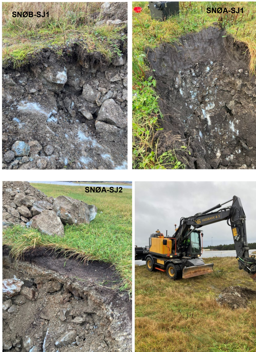
Figur 27. Sjaktgraving ved snødeponier mellom terminalbygget og rullebanen på Haugesund lufthavn november 2021.
