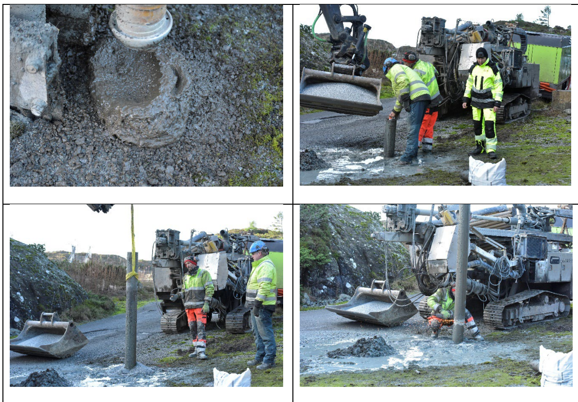
Figur 17. Bildene oppe fra venstre viser de seige parafinluktende løsmassene mellom 2-5 m i borehull BØFB-BO16. Til høyre er de slissede stigerørene med sandspiss i bunn satt, og ren grov sand tilsettes foringsrøret. Nede til venstre dras en ny 3 meter seksjon med foringsrør opp for å bli kuttet vha vinkelsliper som vises i bilde nede til høyre (Foto: Tom Tellefsen).
