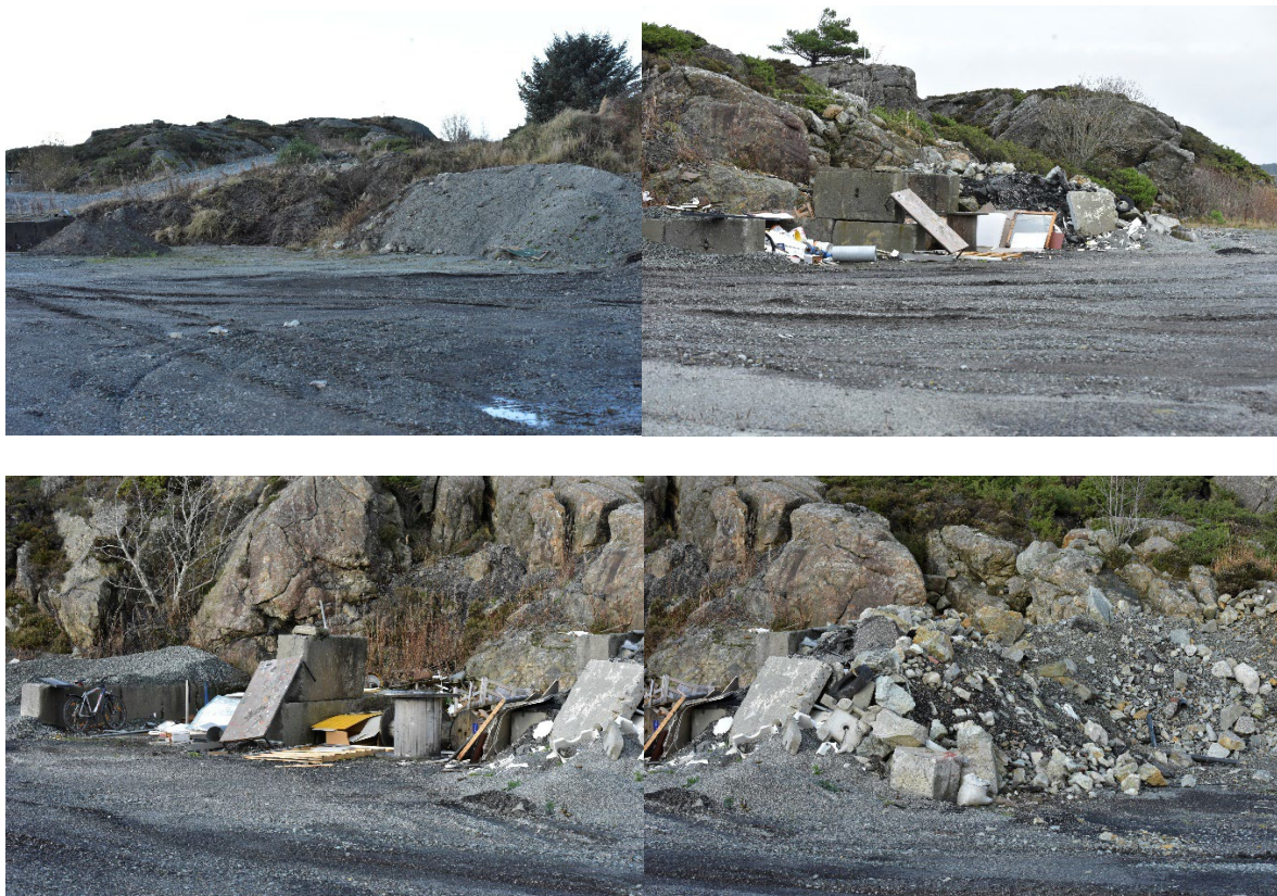
Figur 10. Situasjonbilder fra BØFB ved Haugesund lufthavn høsten 2021. Bildene oppe fra venstre viser mellomlagring av jordmasser og sand med singel. Til høyre vises store betongelementer, plast- og metallspann/kanner, en ventilasjonsrørstuss, forskalingsmaterialer, knuste gipsplater og gamle vinduer. Bilde nede er tatt fra motsatt side av bilde oppe til høyre og viser tomme kabeltromler, isopor og rester av plastrør. Bilde nede til høyre viser en stor haug med inneholdene knust betong, asfalt, stein, pukk og grus (Foto: Tom Tellefsen).
