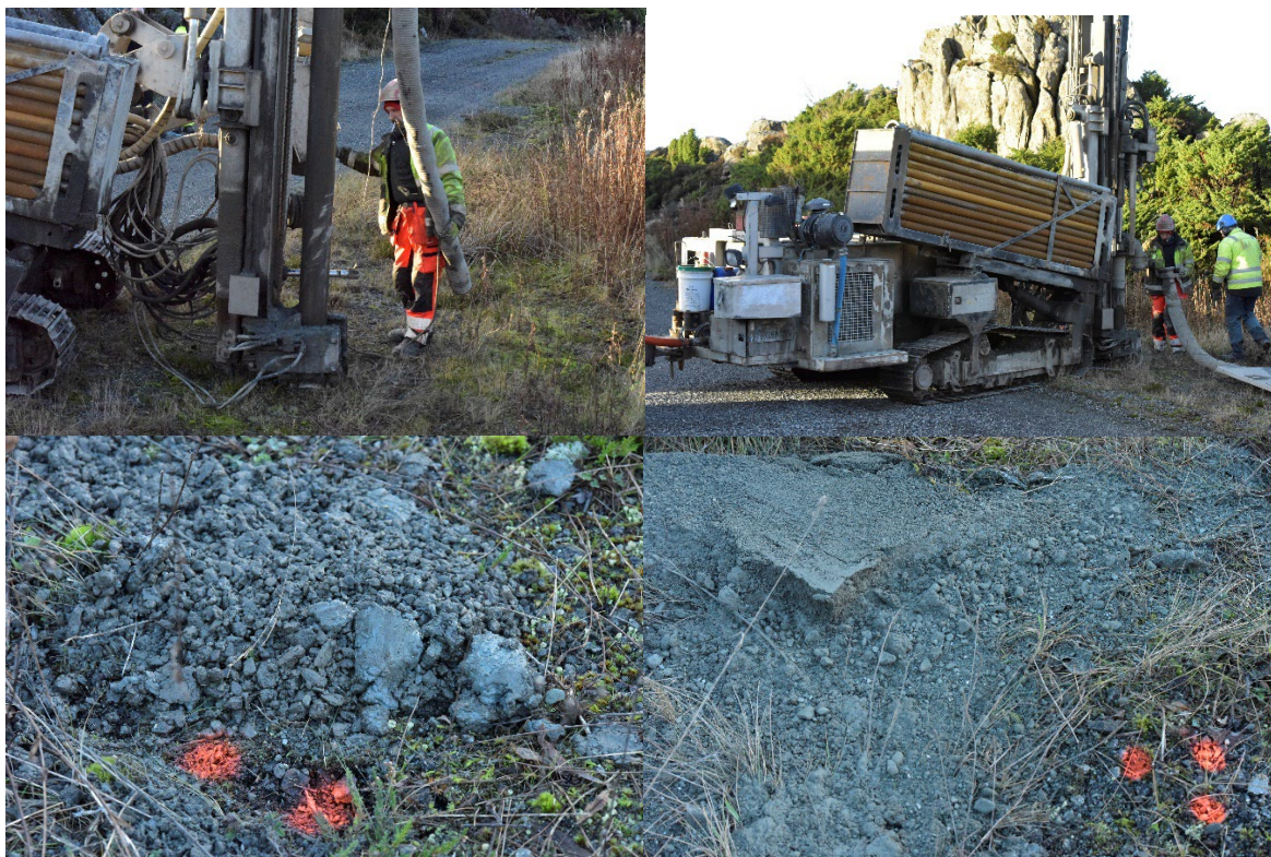
Figur 23. Bilde øverste til venstre og høyre viser rigging og bruk av ODEX-rigg i prøvepunkt BO15. Bilde nede til venstre viser sammensetningen av løsmasser fra prøvepunkt BO15 mellom 1-2 meter (2 oransje rundinger), og nede til høyre viser løsmasser fra samme prøvepunkt mellom 2-3 meter (3 oransje rundinger) (Foto: Tom Tellefsen).
