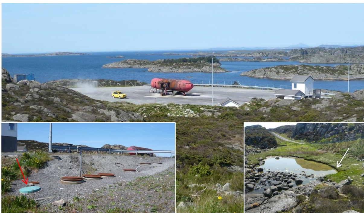
Figur 5: Aktivt brannøvingsfelt – Haugesund, sett mot nord. Venstre bilde: Oljeutskiller med prøvetakingskammer (rød pil). Høyre bilde: Bukten nedstrøms oljeutskilleren med inn- og utstrømning av sjøvann (hvit pil: prøvetakingspunkt).
