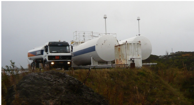
Figur 1: Nåværende drivstoffanlegg Jet-A1 med to dagtanker.
