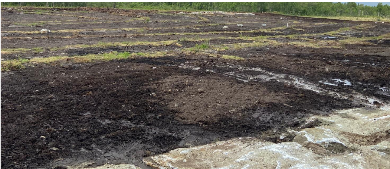
Figur 6: Ferdig utlegg torvmatter og torvjord sett fra sørøst mot nordvest i delområde 6.
