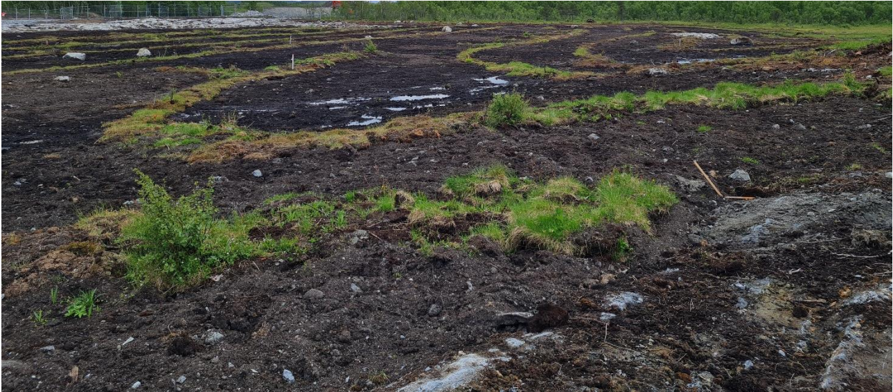
Figur 5: Ferdig utlegg torvmatter og torvjord sett fra nord mot sør i delområde 7.
