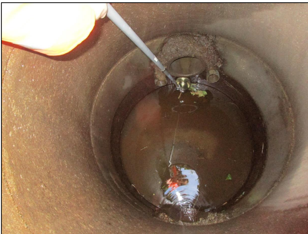
Figur 4: Kum (eksemplifisert ved punktet OV N 2 – se Figur 6 for plassering) som viser kombinasjon av drensrør og overvannsrør som finnes langs takse- og rullebane.
