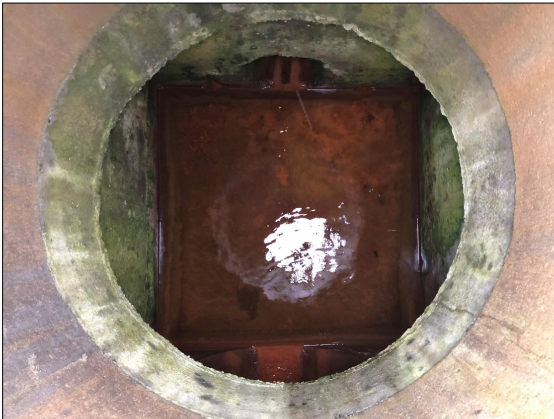
Figur 5: Ren overvannskum uten tilførsel av drensvann (eksemplifisert ved OV-SV 2, se Figur 9 for plassering).
