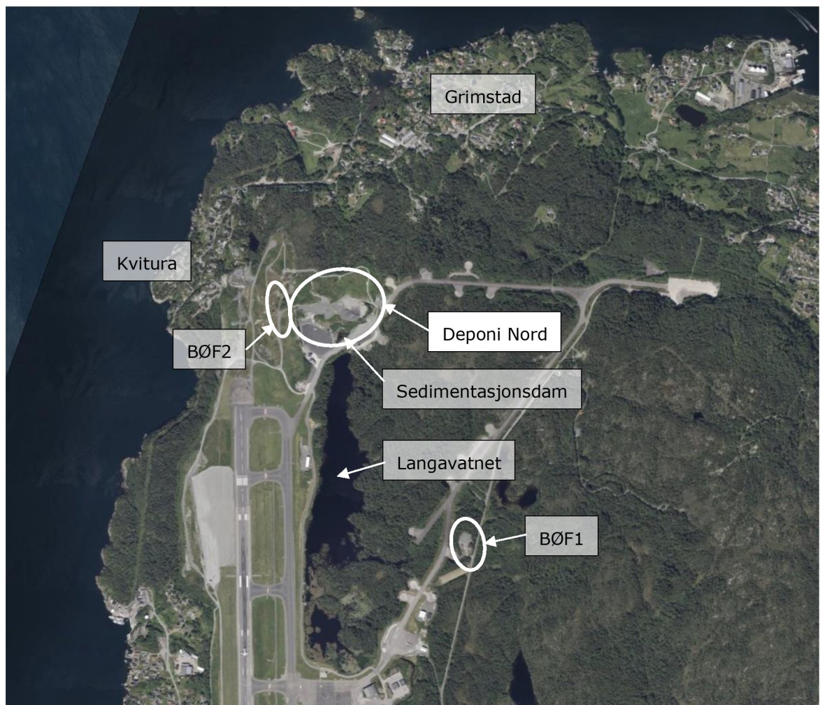
Figur 4 Flyfoto fra norgeskart.no med angivelse av omtrentlig plassering av brannøvingsfelt og Deponi Nord.
