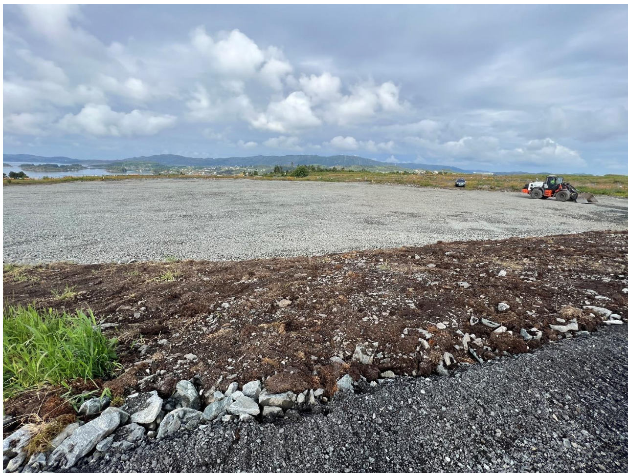
Figur 2-3: Tiltaksområdet etter tilbakefylling med tilførte masser.
