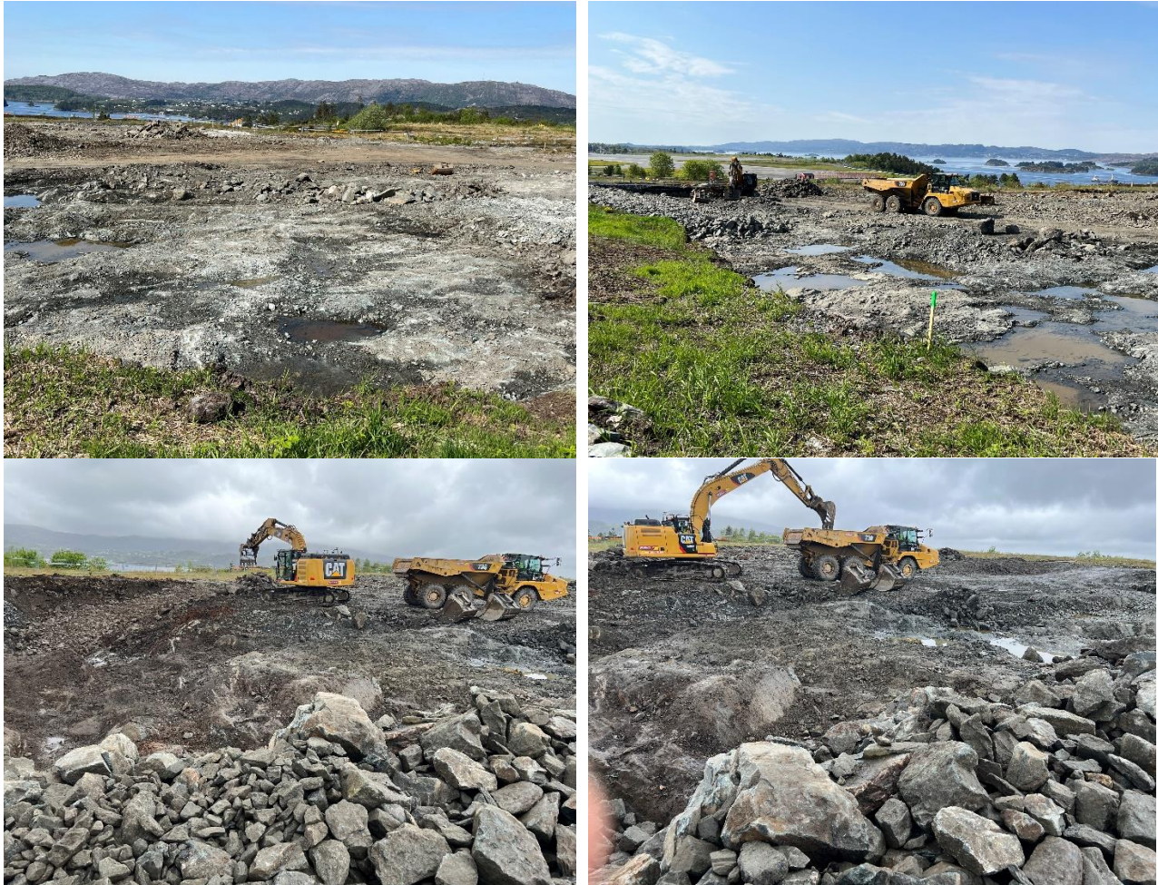
Figur 5-2: Tiltaket omfattet utgraving av masser ned til underliggende berg innenfor hele det aktuelle utgravingsområdet.
