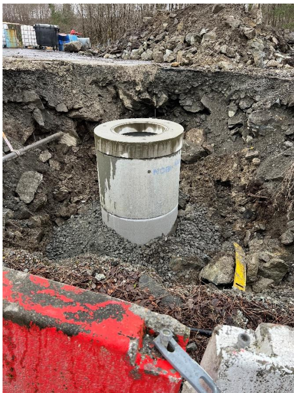
Figur 2-3: Etablering av løsning for oppsamling av avrenningsvann i delområde 1 og 2 (venstre bilde) og utgraving av forurensede masser i delområde 3 (høyre bilde).
