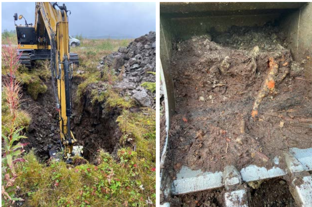
Figur 3-9: Massene på gammelt brannøvingsfelt (BØF2) er generelt karakterisert av grove fyllmasser i varierende mektighet (<0,5 - >4 m) over fjell eller underliggende torv (venstre bilde). Det ble under supplerende undersøkelser påtruffet dypere liggende torv i tre av sjaktene. Denne var svært komprimert og middels omdannet, med noe fibrig struktur og synlige planterester (høyre bilde).
