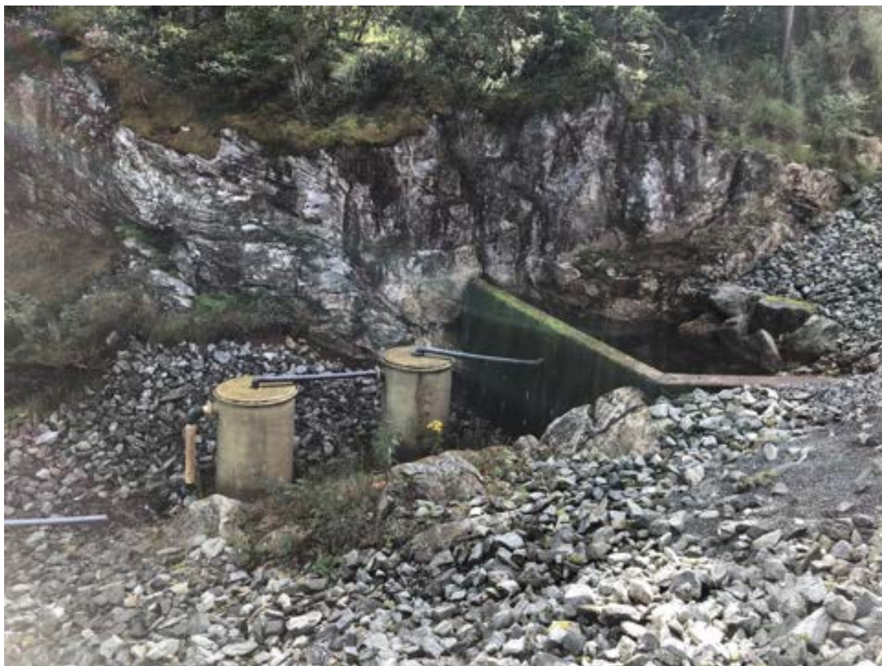
Figur 7-2: Etablert rensetiltak for avrenning mot Steinfjelltjern.
